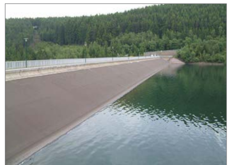
Überlauf und Staumauer
